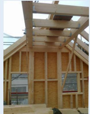
Zur Nutzung als moderne Kindertagesstätte wurde das alte Schulgebäude generalsaniert. Neben dem Innenausbau und der Gebäudetechnik, bedurften der Dachstuhl und das Fachwerk besonderer Sorgfalt. Zahlreiche schadhafte Hölzer der Fachwerkkonstruktion wurden ausgetauscht.
